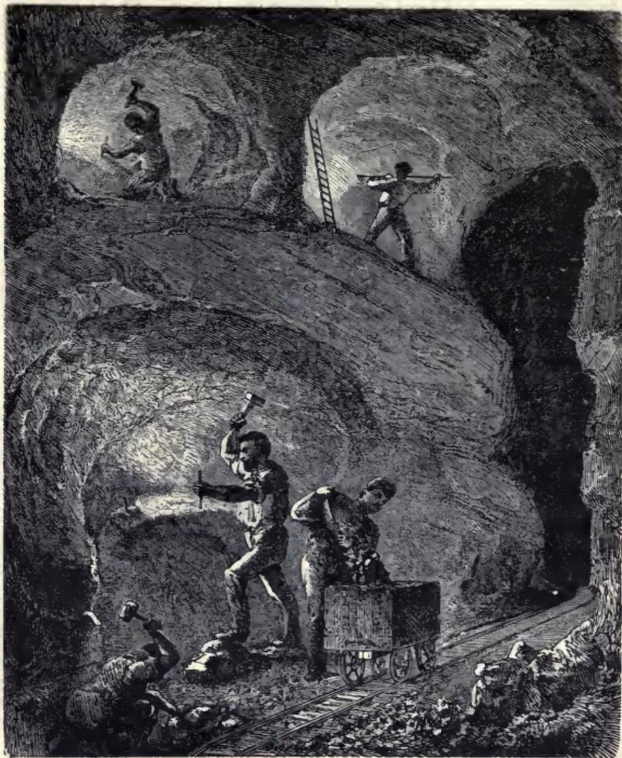
FIG. 46. — Travail d'exploitation dans une galerie de mine.
