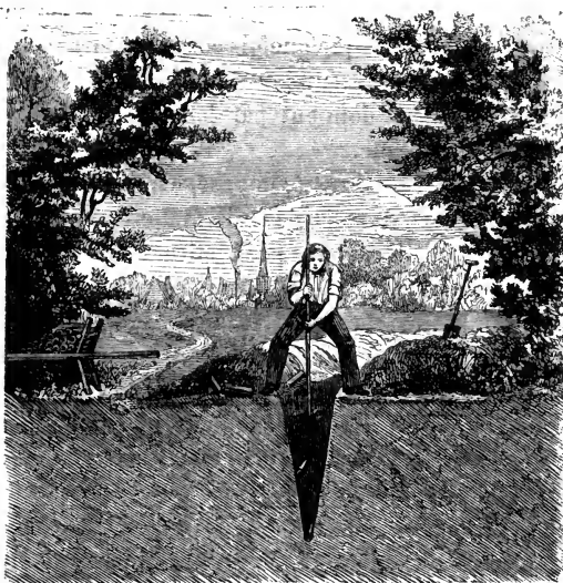
FIG. 9. — Installation d'un drainage. Placement des tuyaux en terre cuite perméable (drains) au fond de la rigole.
