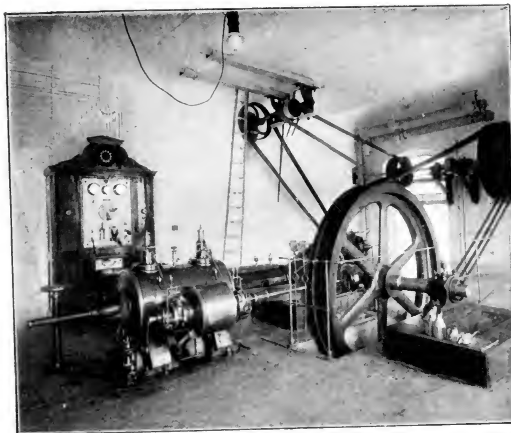
Teilansicht des Maschinenhauses mit elektrischer Anlage.
