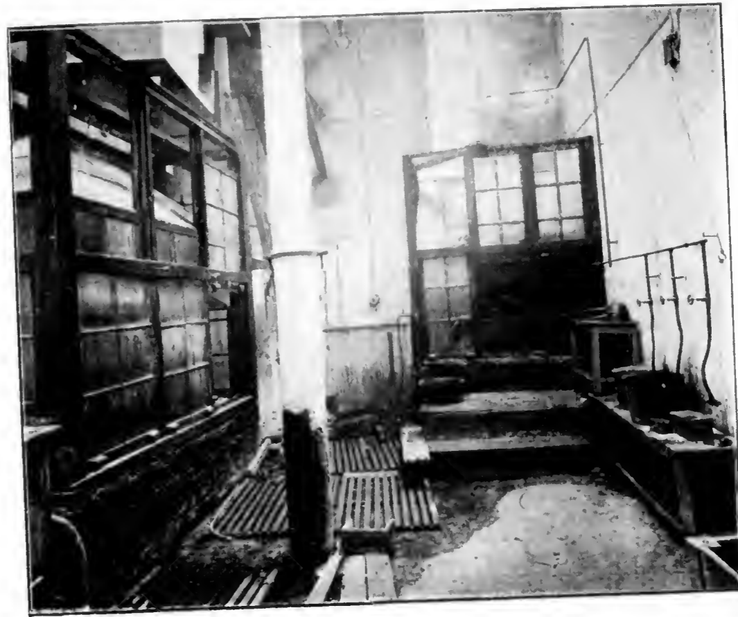
Teilansicht der Galvanisierungsanlage
