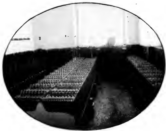
Teilansicht der Akkumulatorenbatterie.
