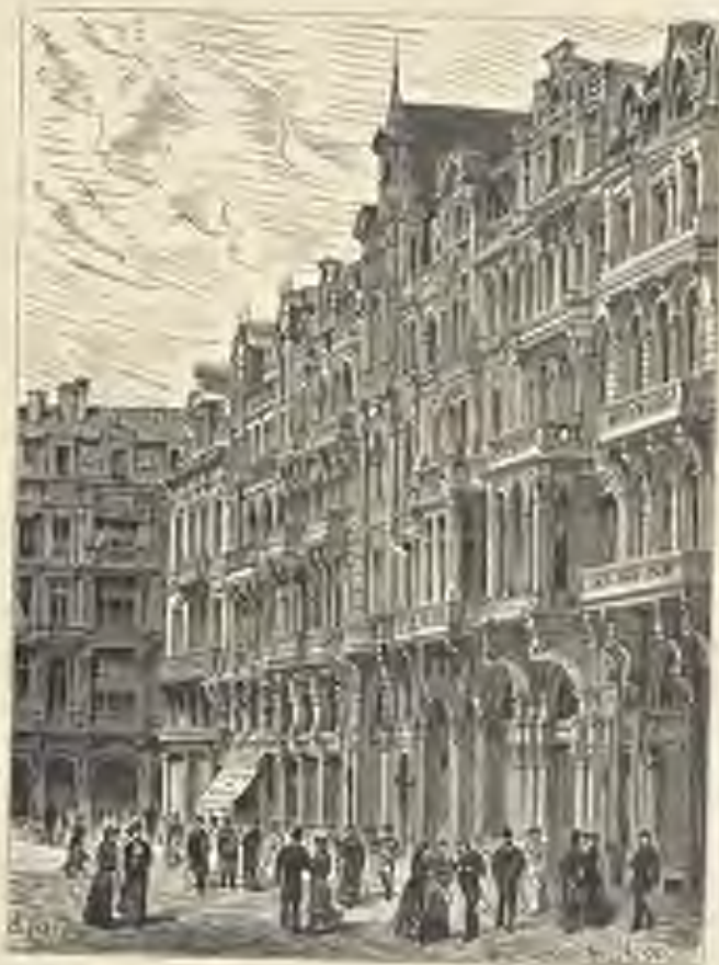
AVENUE DE LA TOUR BRUXELLES.
