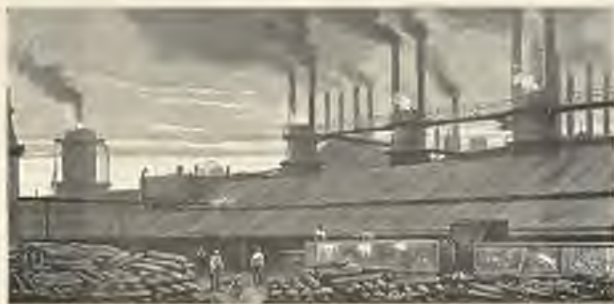
UNE USINE EN HAUT-LEZ, A COULON.
