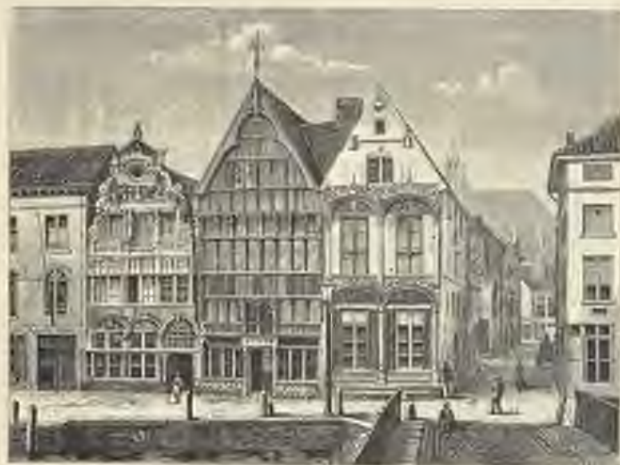
ÉDIFICE DE QUAI AUX ANVERS.
