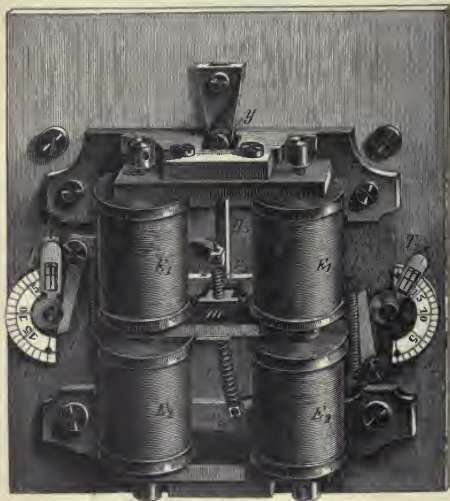
Fig. 356. Elektromagnete des Chronoskops.
