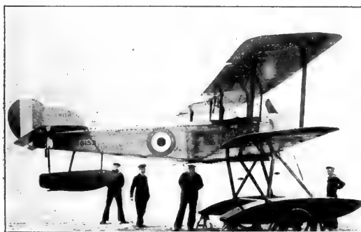
Abbild. 23. Englischer Sopwith-Einsitzer mit Rotationsmotor.
