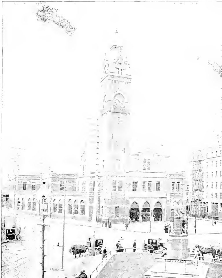
PROVIDENCE STATION N. Y., N. H. & H. R. R., PARK SQUARE.
