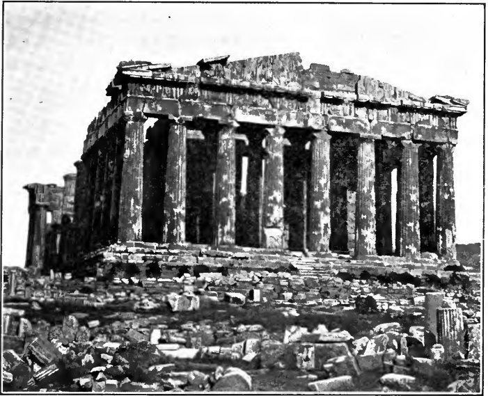
FIG. 114.— The Parthenon. (Photograph.)
