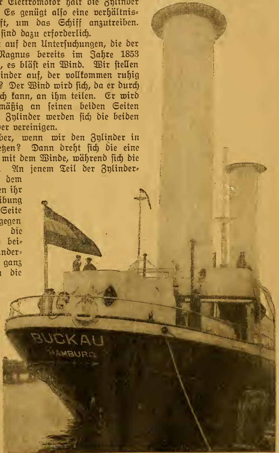
Wie Anton Flettners neues Windkraftschiff aussieht.
