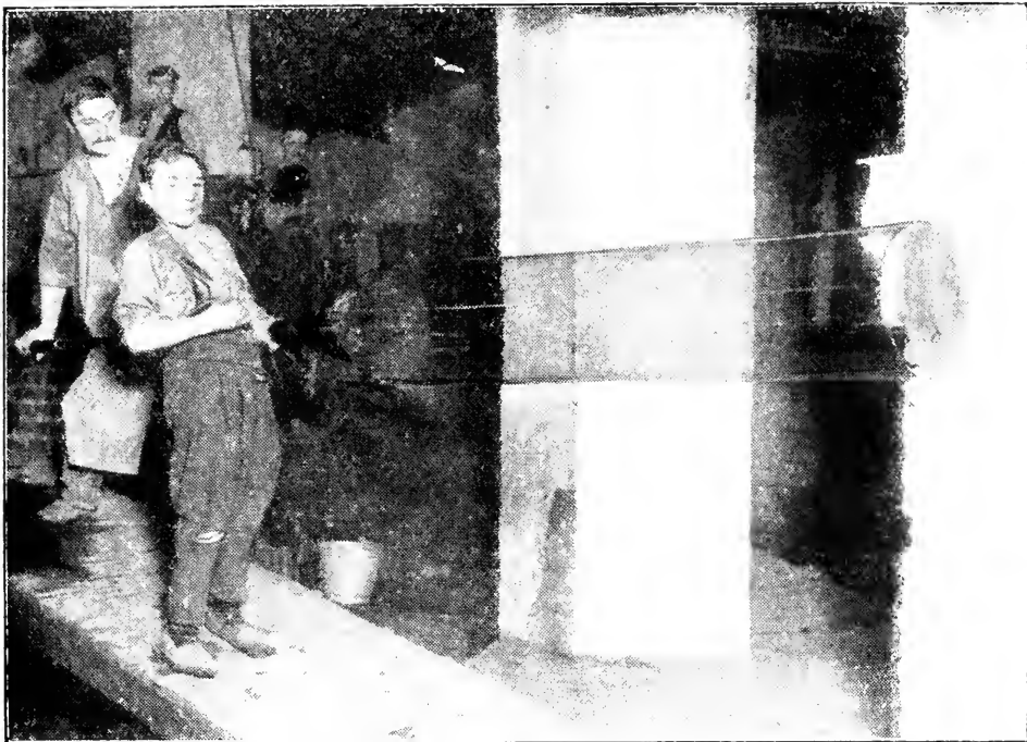
Wie eine Fensterscheibe entsteht: 2. Die geblasene Flasche wird oben und unten geöffnet, so daß ein großer Glaszylinder entsteht.
