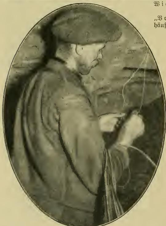
Ein Vorarbeiter („Zehner“) beim Entzünden einer Sprengladung durch elektrischen Strom.
