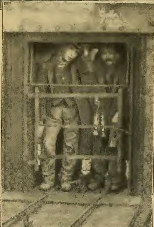
Schichtwechsel: Arbeiter der Nachtschicht werden im Förderkorb „unter Tag“ in die Tiefe gefördert, wo sie ihre Kameraden der Tagschicht ablösen.
