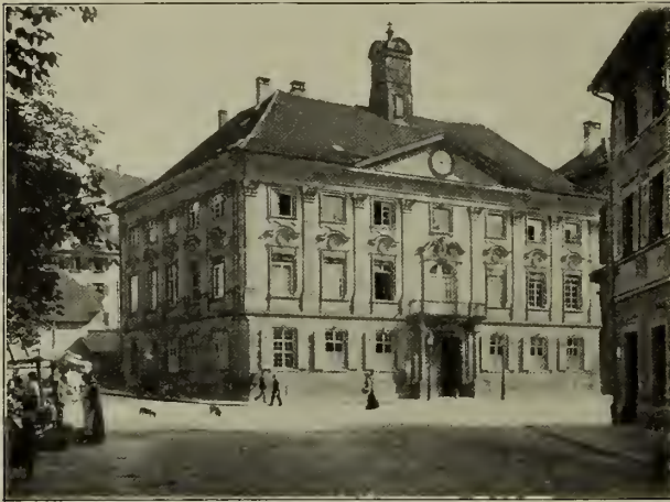
Oberer Palmischer Bau. Jetzt Neues Rathaus Eßlingen Phot. H. Metzger, Eßlingen
