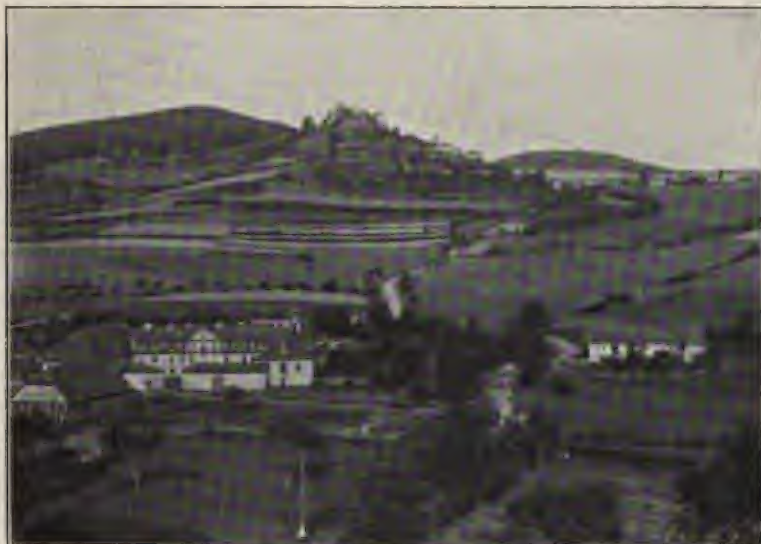
Ehemalige Blaufarbenfabrik Schwarzenfels bei Mottgers — jetzige Oberförsterei Mottgers — mit Burgruinen Schwarzenfels im Hintergrund.
