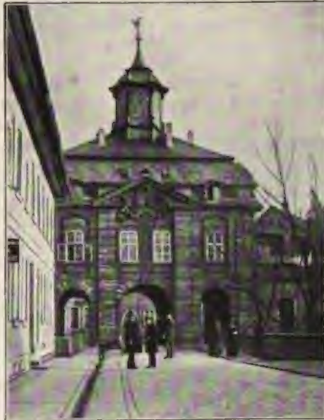
Das Frankfurter Tor in Hanau. Rechts, bis zu Stodwerthöhe, ein Rest des ehemaligen Festungswalles.
