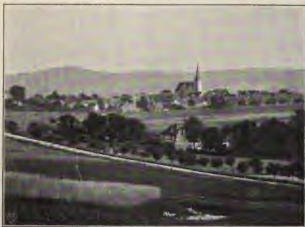
Hess. Lichtenau. (Verlag von E. Keller in Lichtenau).
