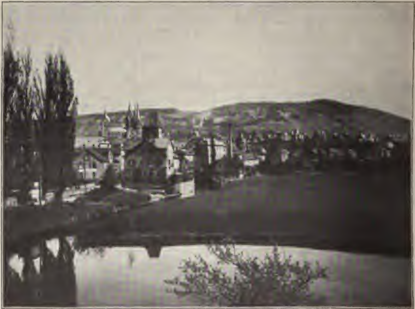
Gelnhausen von der Ziegelbrücke. (Phot. Max Kalm, Gelnhausen.)
