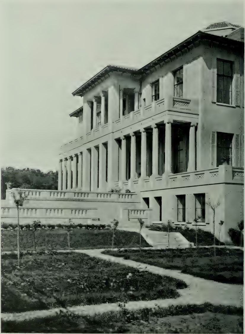
VILLA IN HET PARK „ZORGVLJET” TE 'S-GRAVENHAGE.
