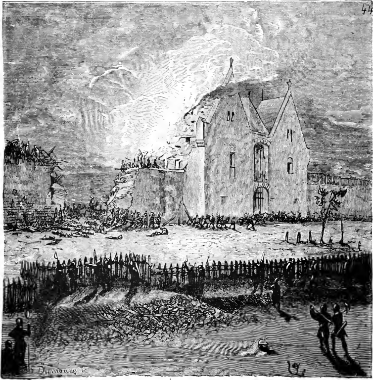
LA BRÈCHE ET L'INCENDIE DE LA PORTE DU NORD
