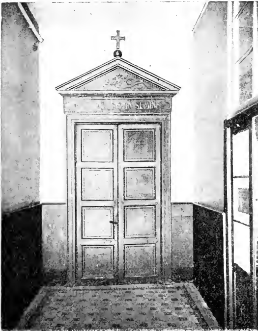
Entrée intérieure de la rue de Pontoise.
