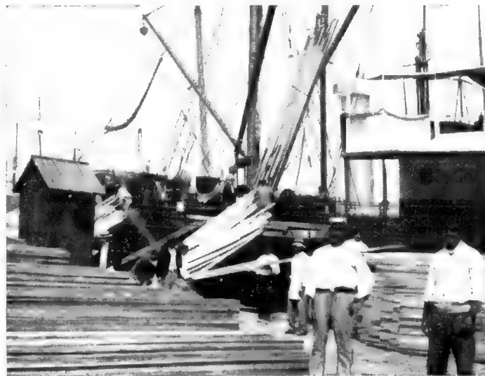
Déchargement du bois de Norvège dans un port français.
