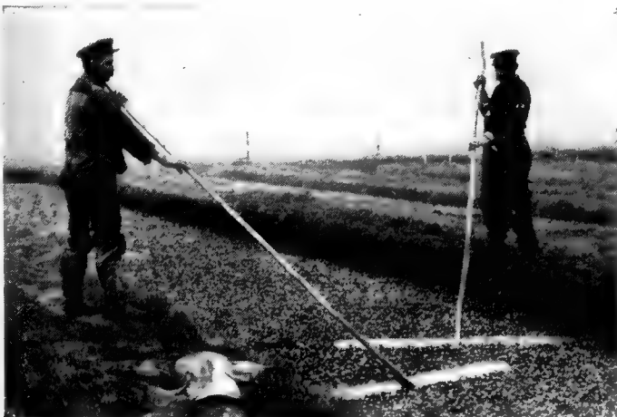
Schuellage ou tassement du Cresson.
