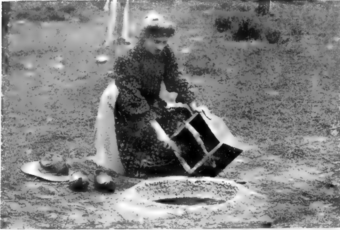
Mise de la résine dans un tonneau enterré.
