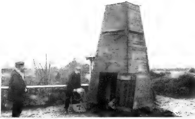
Cheminée d'aération d'une champignonnière.
