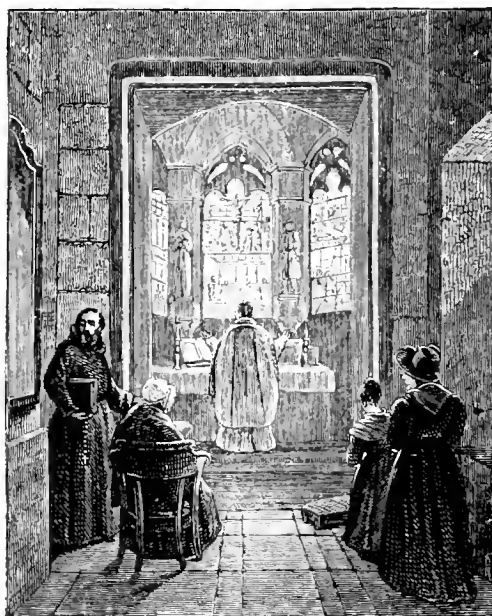
GGANLE. — CHAPELLE SOUTERRAINE.
