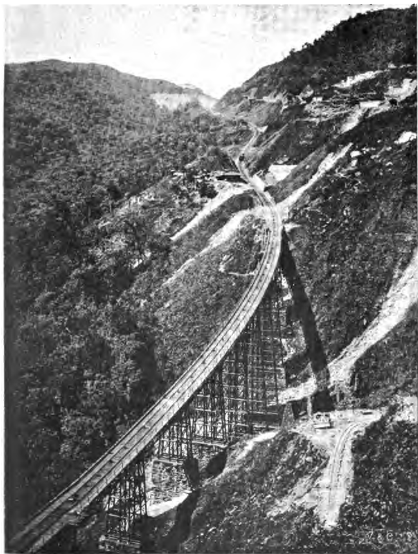
VIADUCTO DA GROTA FUNDA NA LINHA VELHA DA SERRA (S. Paulo Railway Company)
