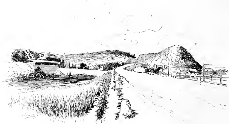
CATALUÑA — Túnel de Mongat. (Primero en España).
