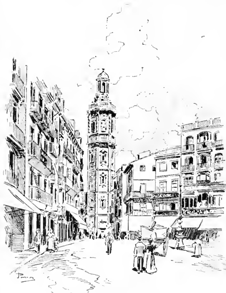
VALENCIA — Plaza y Torre de Santa Catalina.
