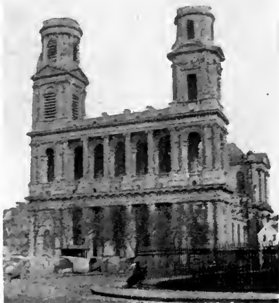
FIG. 183.—FAÇADE OF ST. SULPICE, PARIS.
