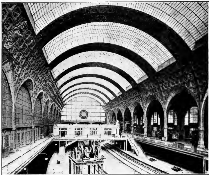
FIG. 278—GARE DU QUAI D'ORSAY. INTERIOR. (LE GENIE CIVIL)
