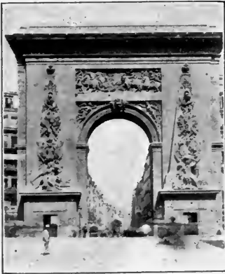
FIG. 241—PARIS. PORTE SAINT DENIS. PRINCIPAL FRONT
