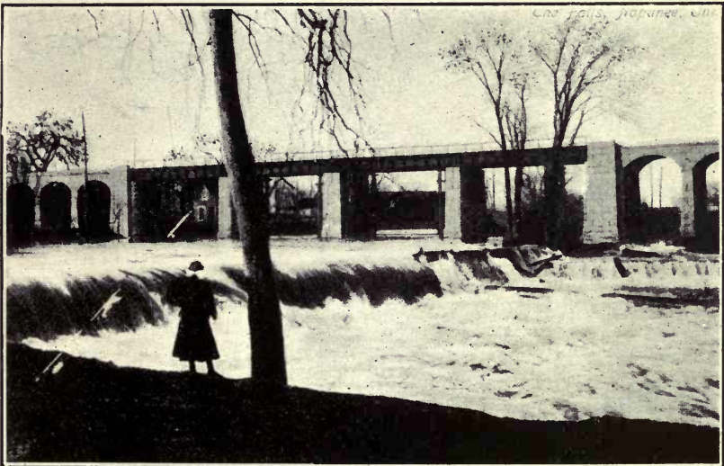
G. T. R. BRIDGE, NAPANEE. BUILT 1855.
