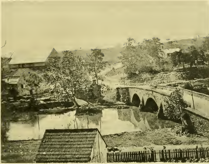
ANTIETAM BRIDGE, MD.
