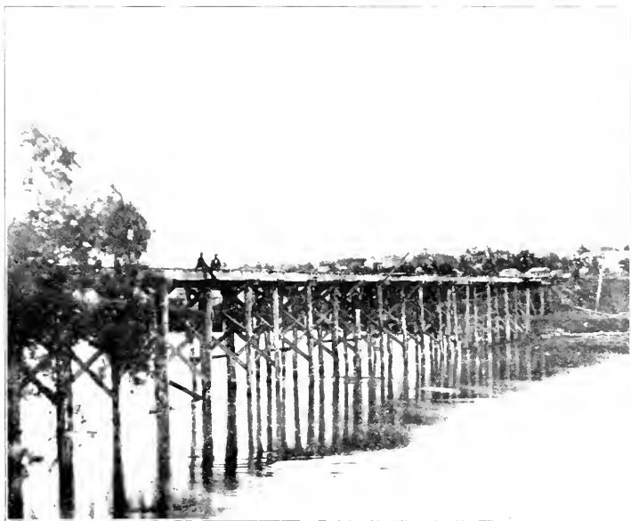
OLD C. B. & Q. R. R. BRIDGE, AURORA.
