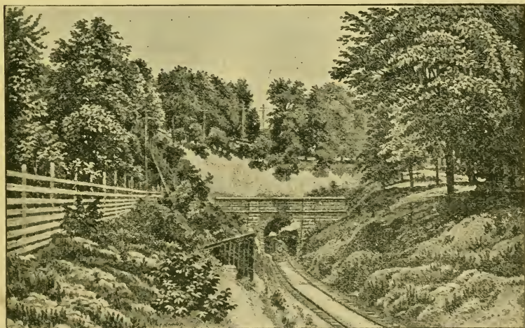
TUNNEL ON N. C. & ST. L. RAILROAD.
