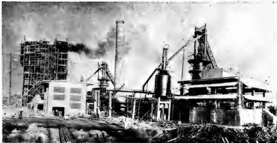
照片5 正在加紧施工的广州钢铁厂的一角 (陈福北, 新华社)
