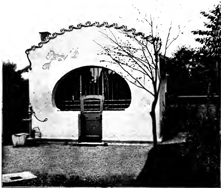
PUMPENHAUS VILLA-FRIED. MANN HINTERBRUHL
