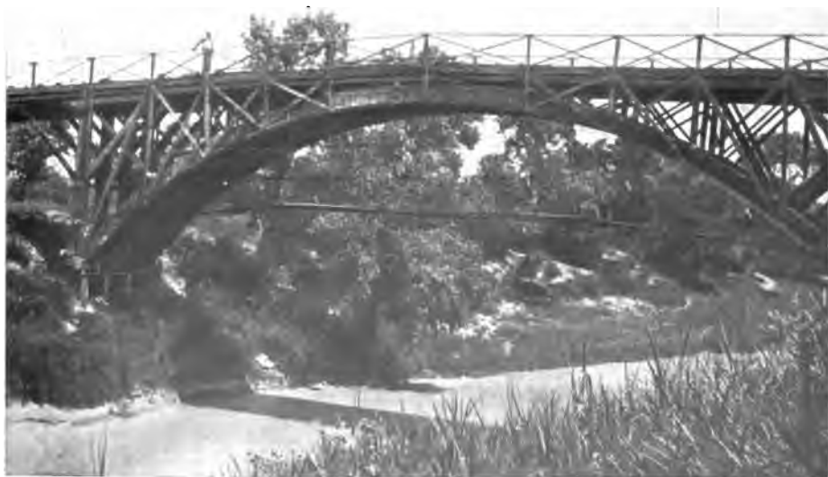
RIPALTA — IL PONTE SUL FORTORE.
