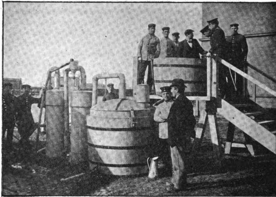
Fig. 3. Wasserstoff-Erzeuger für den meteorologischen Drachenballon.
