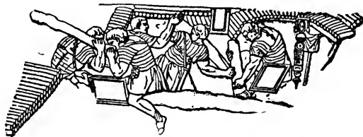
Fig. 124. Costruzione di una trincea. (Bassorilievo romano).
