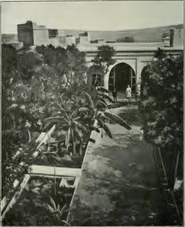
Garten und Amtsgebäude des deutschen Konsulats in Fes.
