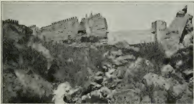
Vom Uad Fas unterspülte Stadtmauer von Fas.
