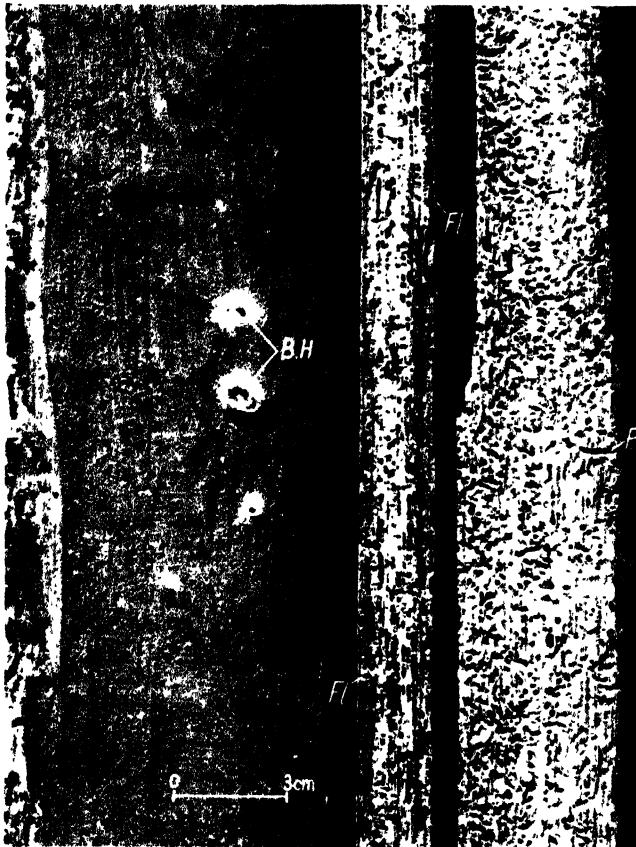
Abb 1 Kiefern Brett (Kellertur), von Anobium punctatum zerstört Links: Oberfläche mit Fluglochern (Fl) und Bohrmehl-Haufchen (B.H.), Mitte: Querschnitt durch das gleiche Brett, Rechts: eine der allein vom Fraß verschonten Herbstholz-Lamellen. (P. Puppenwiege). Aufn.: Staatliches Materialprüfungsamt Berlin-Dahlem, Institut für Werkstoff-Biologie.
