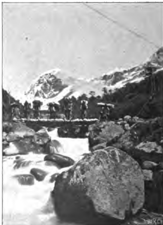
Brücke beim Hirtenplatz Thangem; im Hintergrunde der Pandim.
