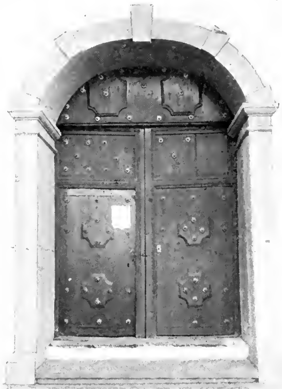
b. ENTRANCE DOORS, SAN LUIS OBISPO
