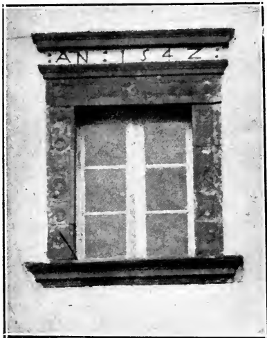
Ventanal de piedra en su forma primitiva, con la fecha en que se construyó el edificio
