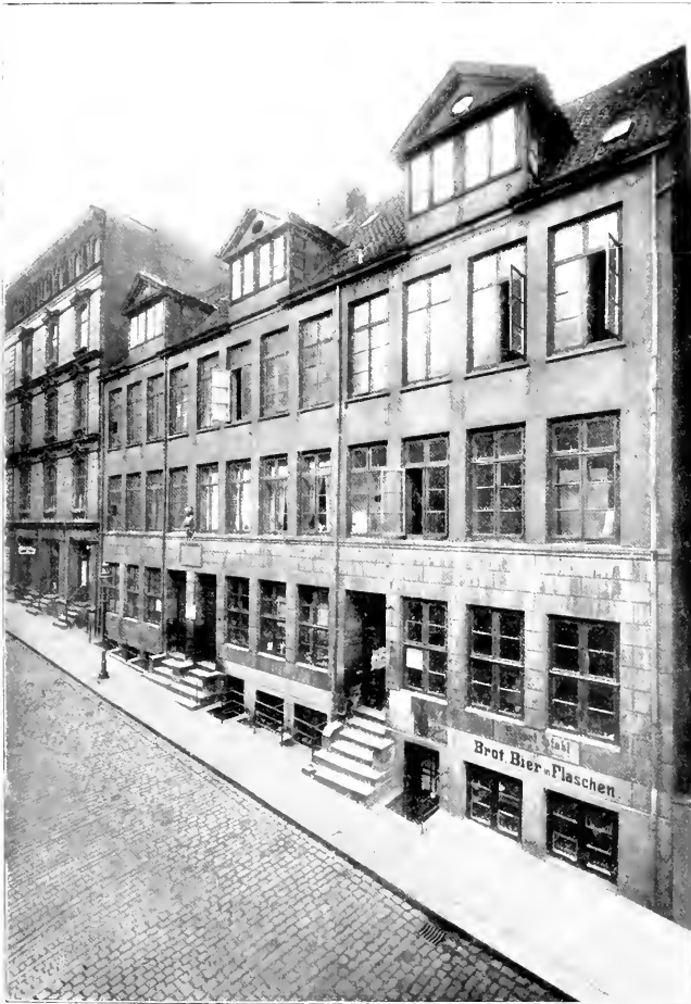
Fig. 8. Ansicht der Häuser Königstraße Nr. 52, Nr. 50 (Klopstockhaus) und Nr. 48 vor dem Abbruch, Herbst 1908.
