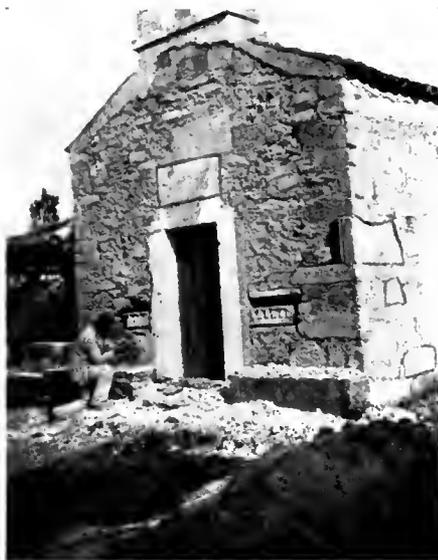
Abb. 4. Nordwestansicht der Kirche nach dem Entfernen des Putzes.
