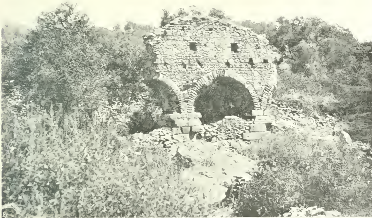
19. Rückwand der Gymnasion-Nordhalle.
