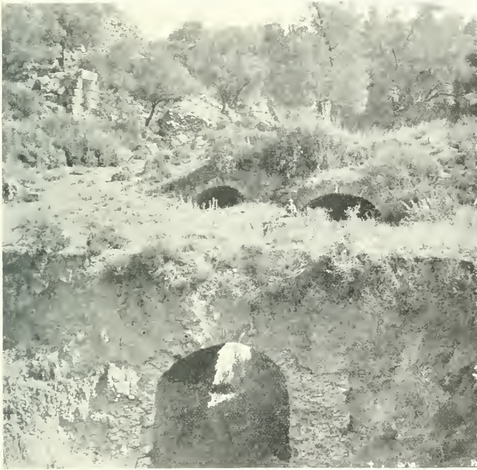
7. Heutiges Westende des Tunnels abgebrochen.
