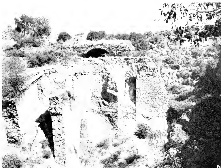
14. Pfeilersubstruktionen des Amphitheaters im Norden.
