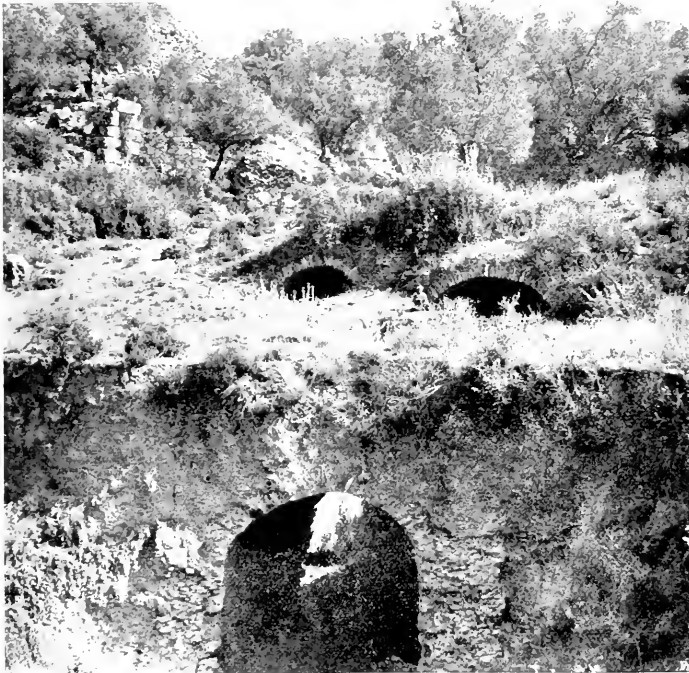
7. Heutiges Westende des Tunnels abgetrieben.
