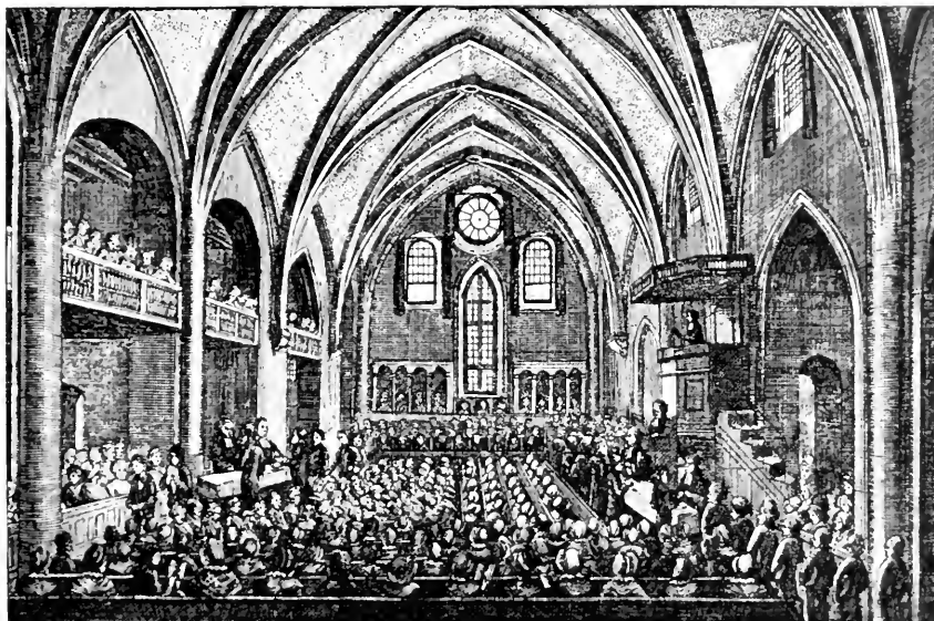
Intérieur du Temple de Saint-Gervais (avant la restauration de 1903). d'après le dessin de P. Escuyer, vers 1825. (page 32.)
