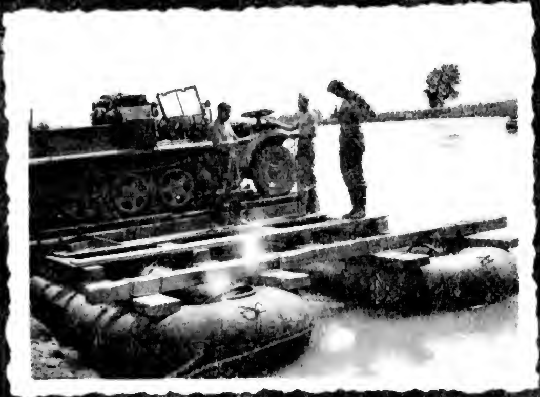
Übergang über den
