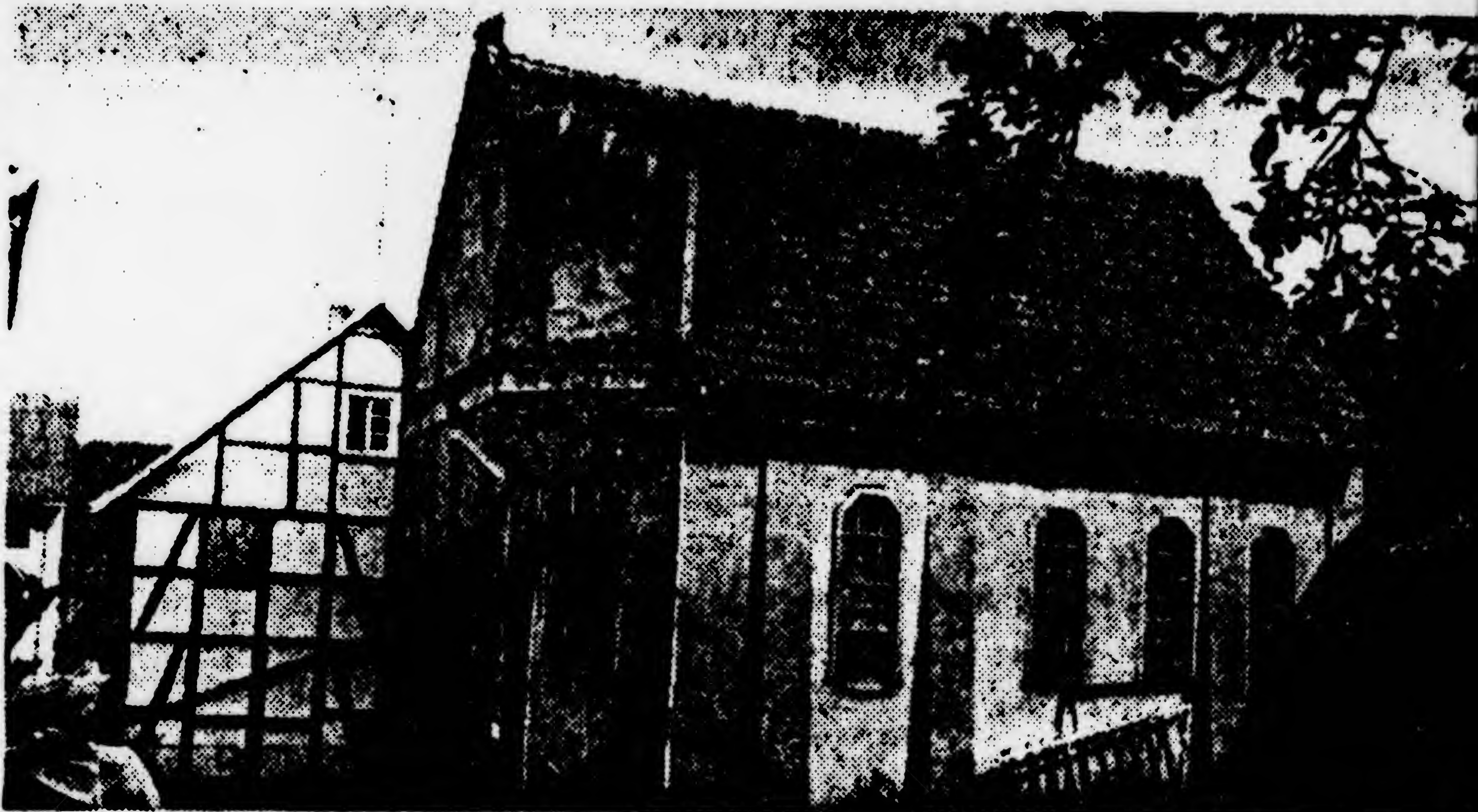
DIE BEBRAER SYNAGOGE in der Amalienstraße. 1938 im Innern total verwüstet, wurde sie wie Rotenburger Gotteshaus nach dem Zweiten Weltkrieg wegen Bauauffälligkeit abgerissen. (Repro-
