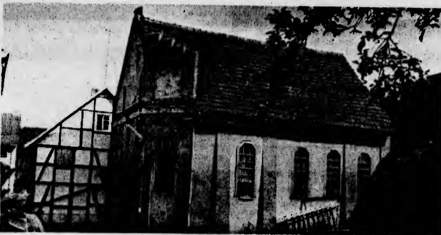
Die BEBRAER SYNAGOGE in der Amalienstraße. 1938 im Innern total verwüstet, wurde sie wie das Rotenburger Gotteshaus nach dem Zweiten Weltkrieg wegen Baufälligkeit abgerissen. (Repro: yey)
