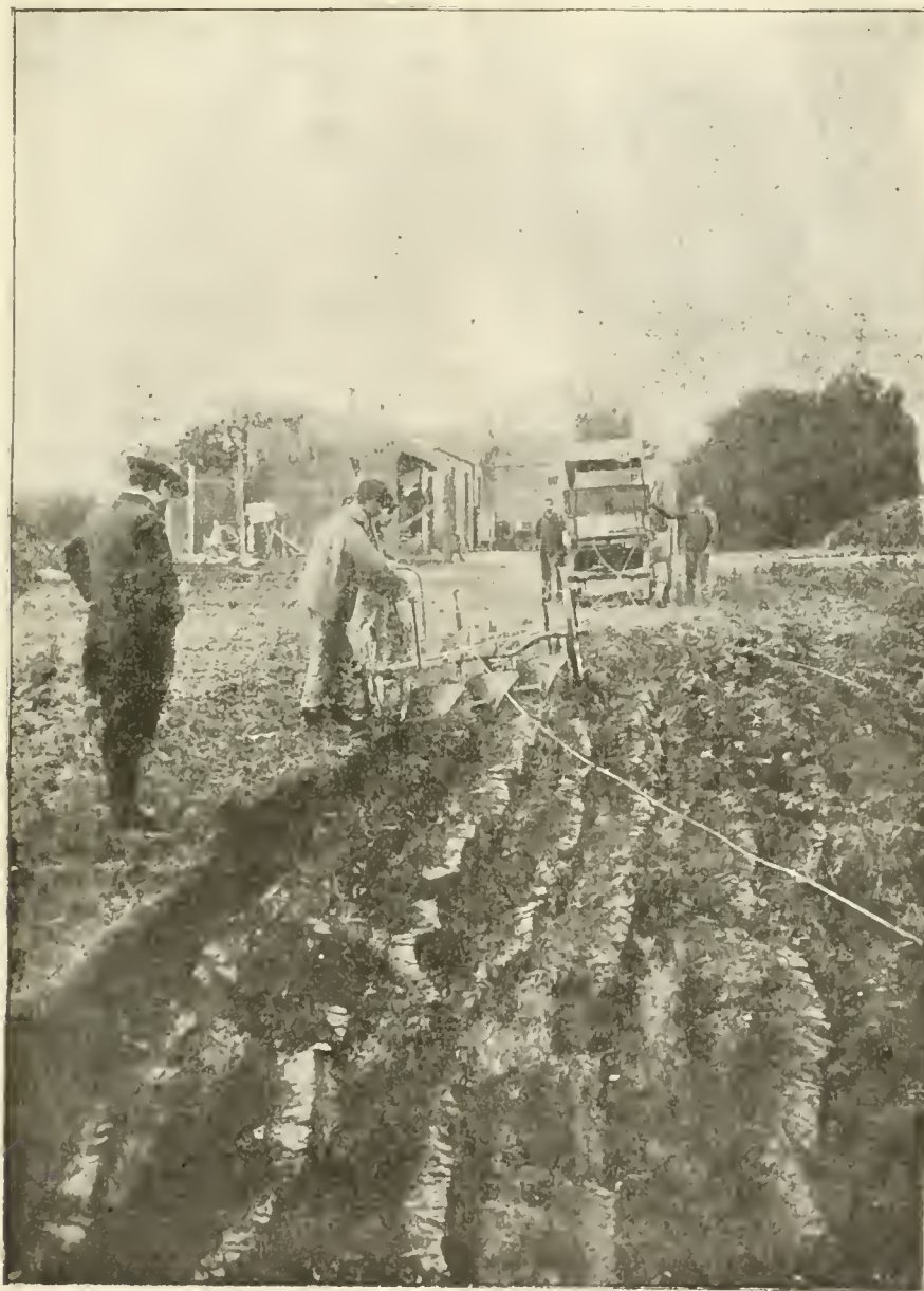
Fig. 53. — Défrichement d'une luzernière à Suresnes avec le treuil automobile A. Castelin.
