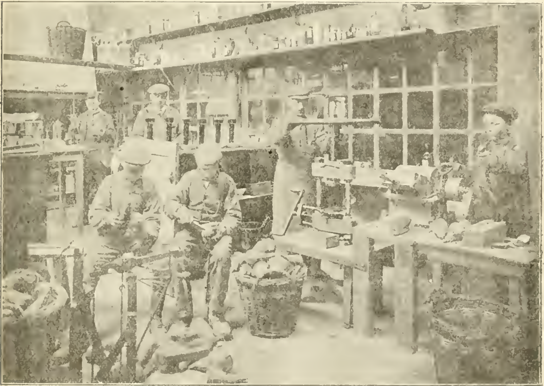
Fig. 149. — Laboratoire de contrôle de la sucrerie de Noyelles-sur Escaut. — Tare et prise de la densité des betteraves.
