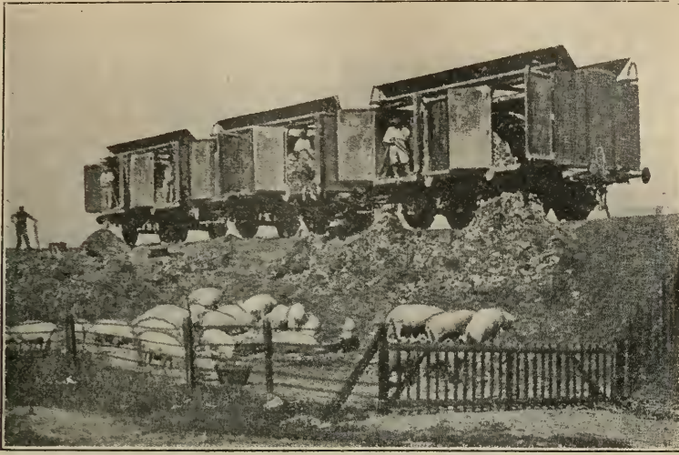
Fig. 37. — Déversement à Witzwil des ordures ménagères de Berne.
