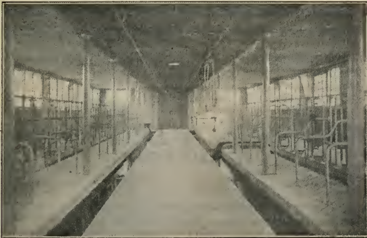
Fig. 33. Transporteur de fumier à suspension desservant une vacherie anglaise
