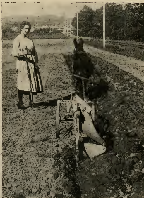
Fig. 82. — Vue arrière du brabant-double Le Maraîcher en travail.
