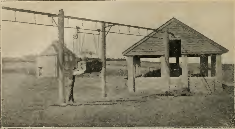
Fig. 34. — Fumière couverte et transporteur aérien venant de la vacherie
