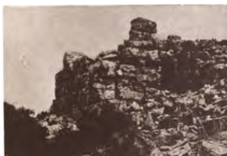
FIG. 5. ALEZEITIN. TOWER ON N. WALL
