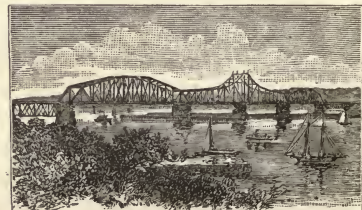
NEW LONDON : THAMES BRIDGE.
