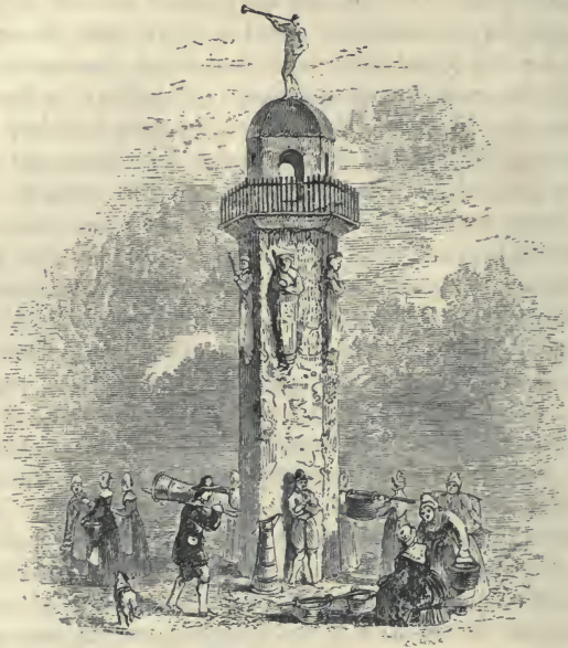
Conduit in Westcheap.
