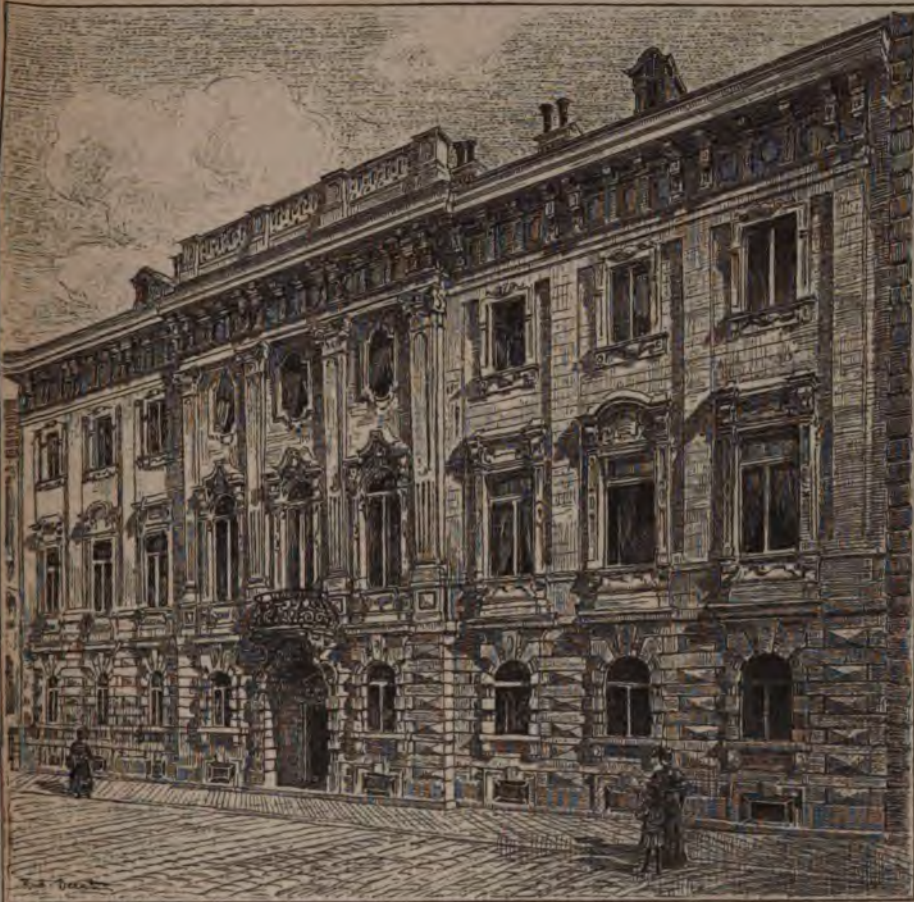
Abb. 97. Modernes Wohnhaus im Barockstil.
