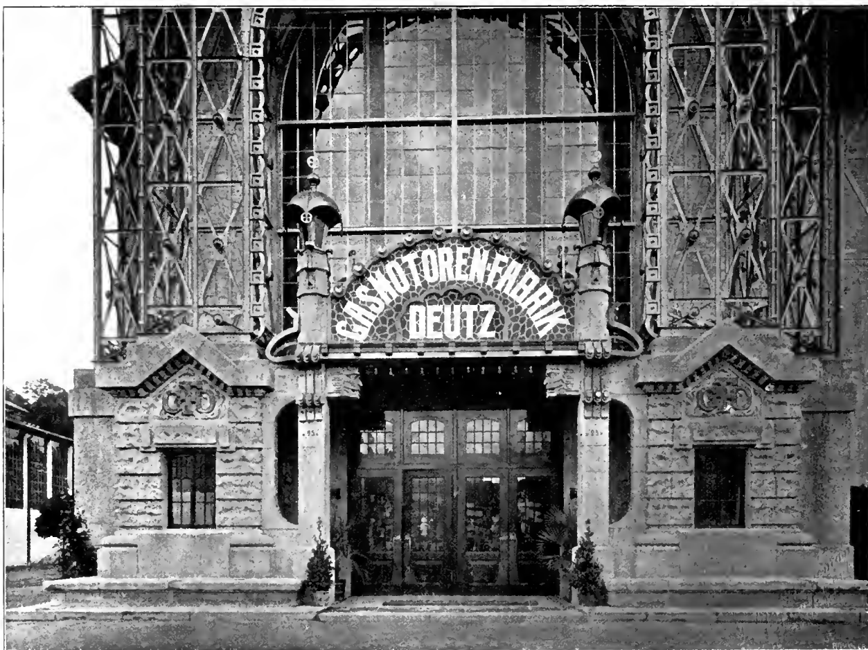
AUSSTELLUNG DÜSSELDORF 1902, AUSSTELLUNGSHALLE DER GASMOTORENFABRIK DEUTZ VON ARCHITEKT B. MÖHRING, BERLIN
